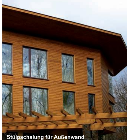
Stülpschalung für Außenwand
