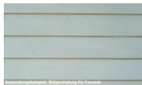
Anwendungsbeispiel: Stülpschalung für Fassade
