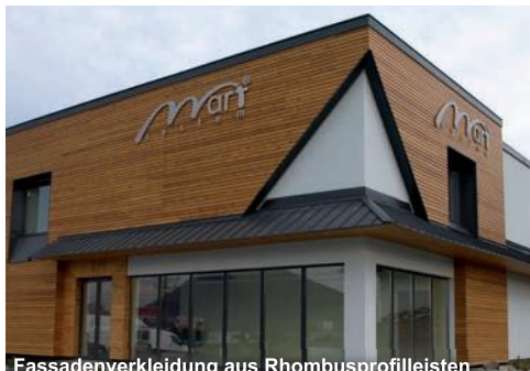
Fassadenverkleidung aus Rhombusprofileleisten
