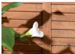
Die an der Unterseite leicht angeschragten Lamellen erlauben - je nach Blickwinkel - eine leichte Durchsicht.
