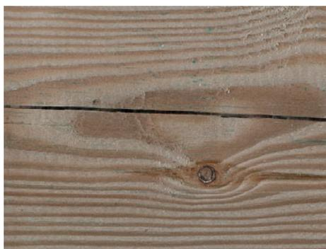
Spannungsrisse durch die Holz Trocknung
