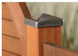
**Konstruktiver Holzschutz:** Schützen Sie die schichtverleimten Hartholzpfeosten zwingend mit Kappen aus Edelstahl, Seite 107.
