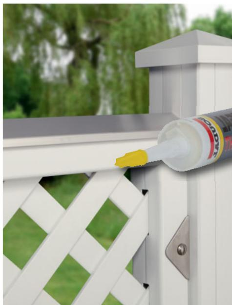
Designaufsatz Alu mit MS-Polymer-Kleber (1398) befestigen.
